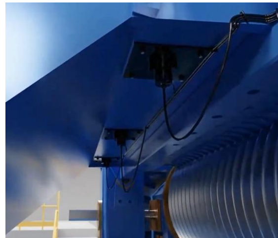
Figura 5 - Exemplos de instalação dos sensores na região de passagem do material.
